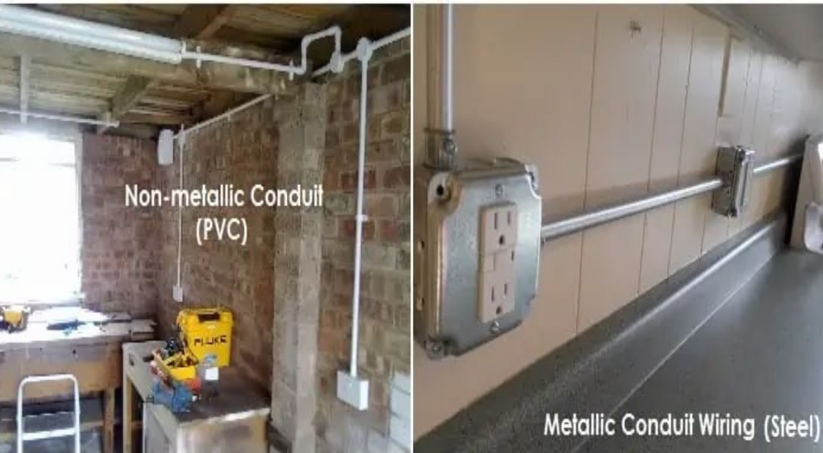
Surface Conduit Wiring
