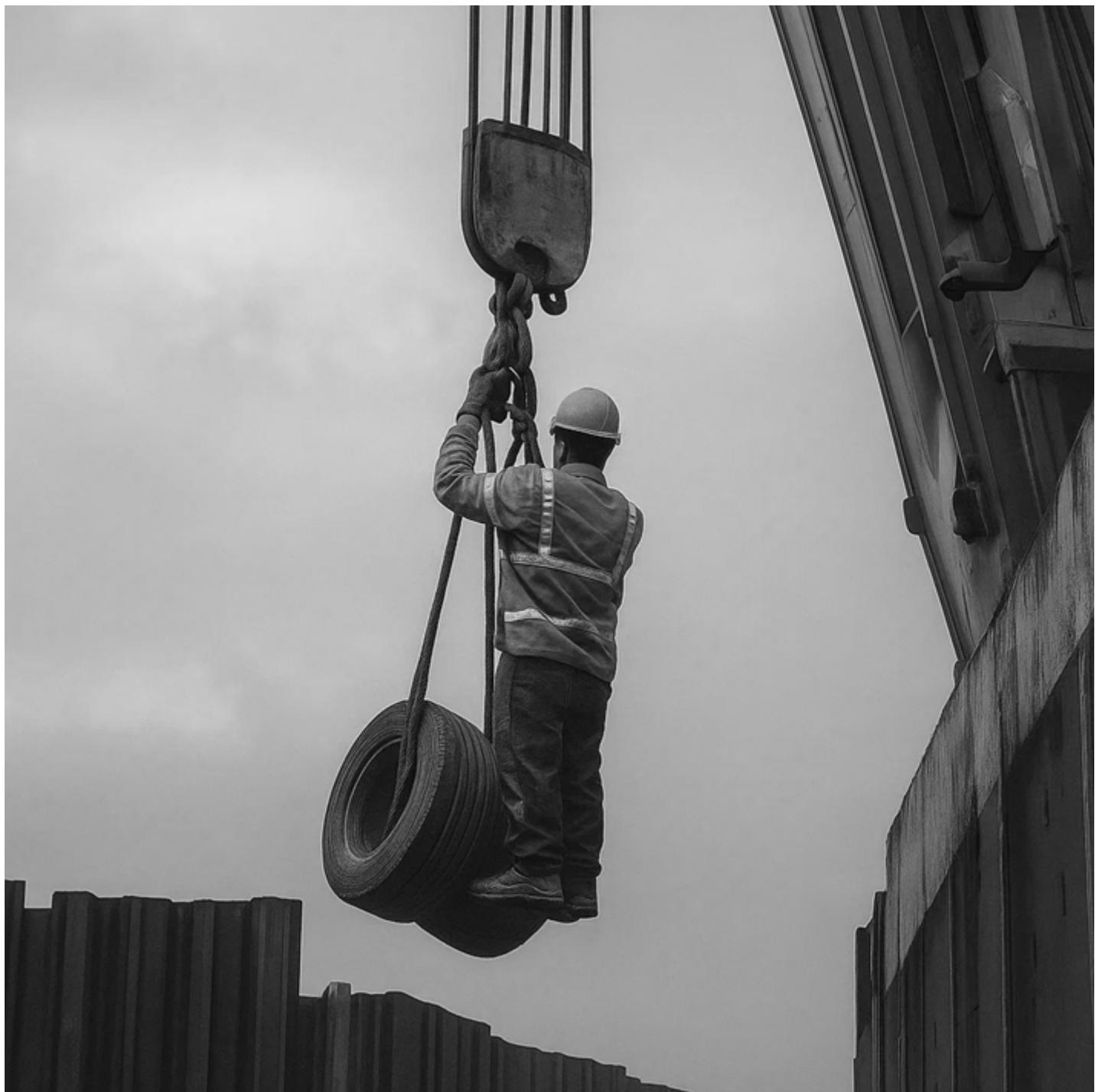
Le travailleur se tient debout sur une charge suspendue (un pneu soulevé par un
