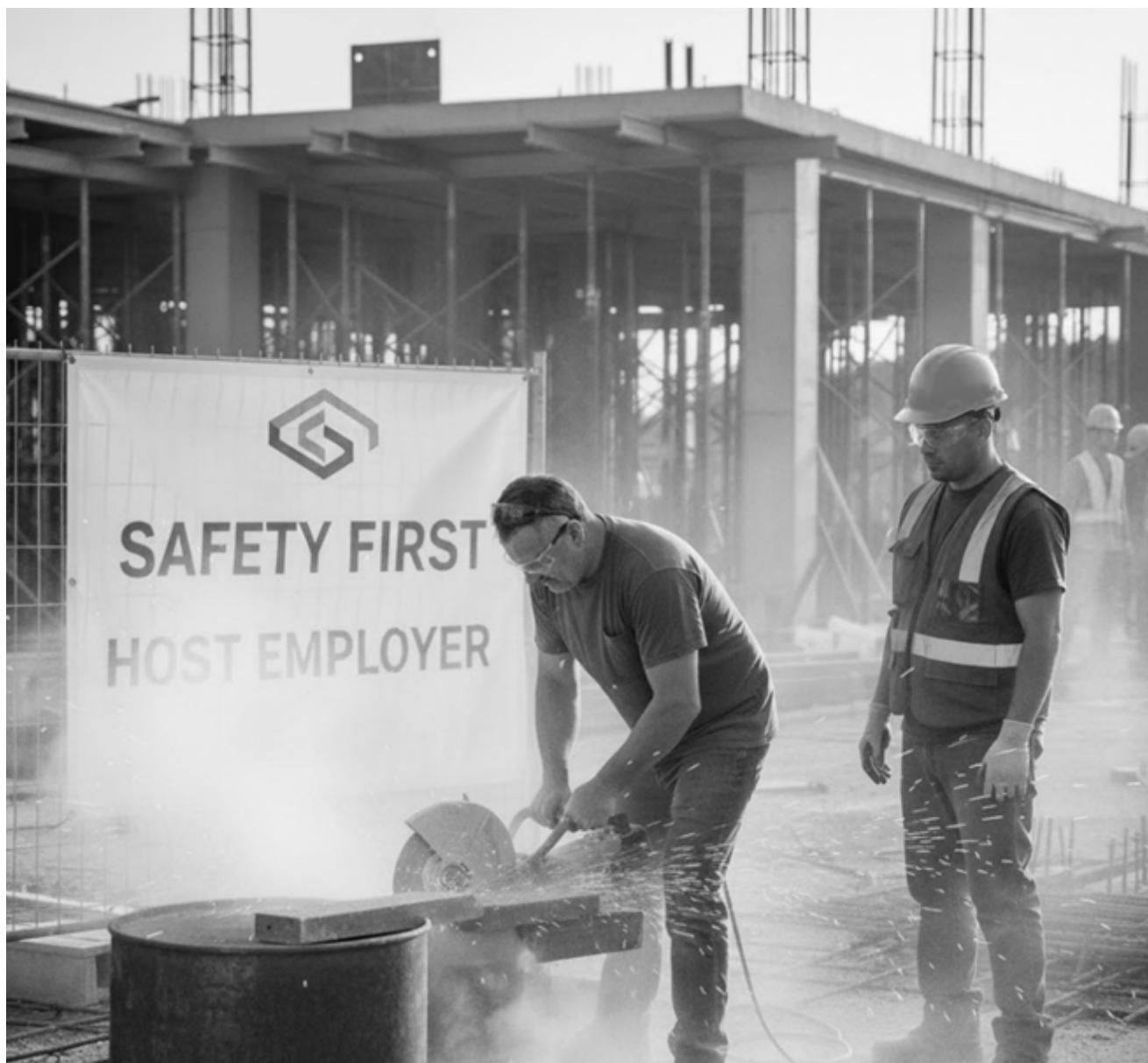
En la imagen, el contratista está cortando metal con una sierra eléctrica, lo que produce chispas y polvo, pero no lleva el equipo de protección personal (EPP) necesario: no tiene pantalla facial, protección auditiva ni protección respiratoria.
