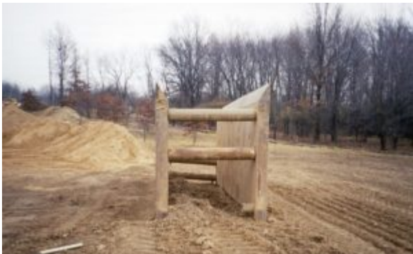
Figura 2. Escudo (El escudo fue retirado de la zanja con una excavadora y colocado a 20 metros de la zanja.)
